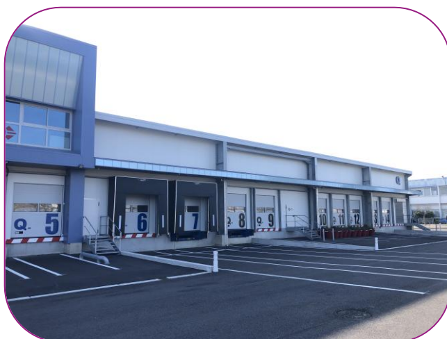
Vue depuis les mises à quais privatives
