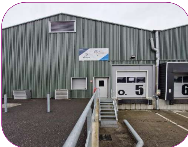
Vue d'une chambre froide
